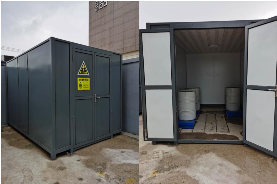
图 4-1 危废暂存库现场照
